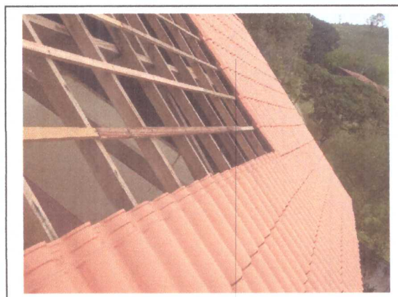
COLOCAÇÃO DAS TELHAS NOVAS
