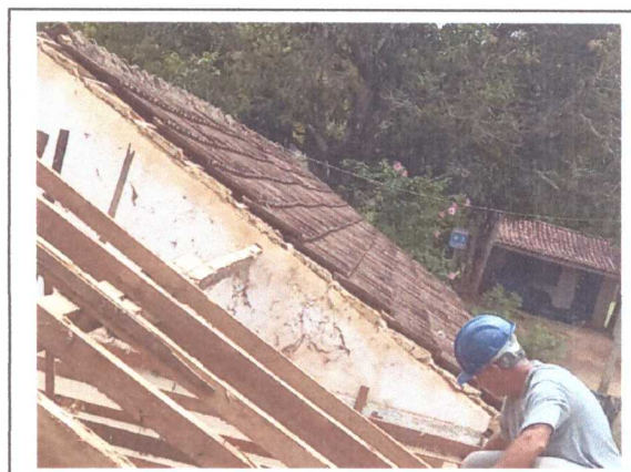
RETIRADA DAS TELHAS
