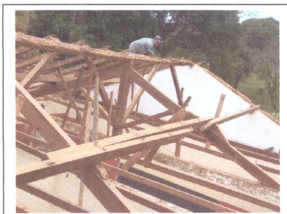
TROCA DOS MADEIRAMENTOS
